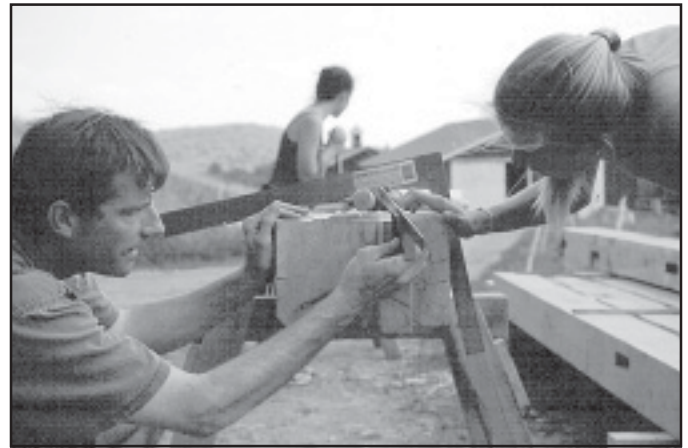
Jack Kruse and Margaret Niemiec (Fall '02) collaborate on a wall post tenon.
